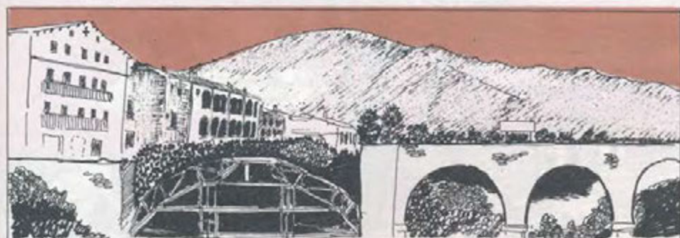
1914. ES COMENCEN LES OBRES DE CONSTRUCCIÓ DEL PONT NOU
